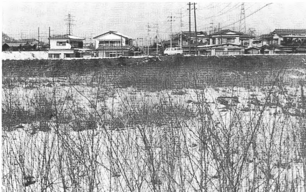
薄根川の堤坊より対岸の白岩地内を臨む
