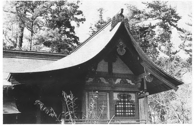
④④ 玉村八幡宮本殿（玉村町）
