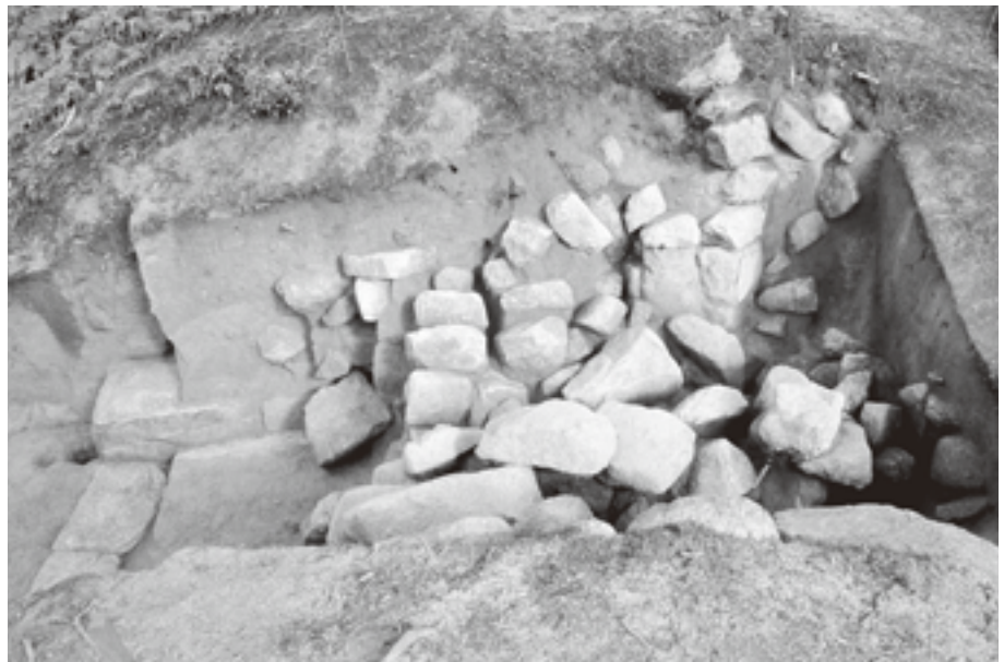
2. 側壁石材の崩落状況
