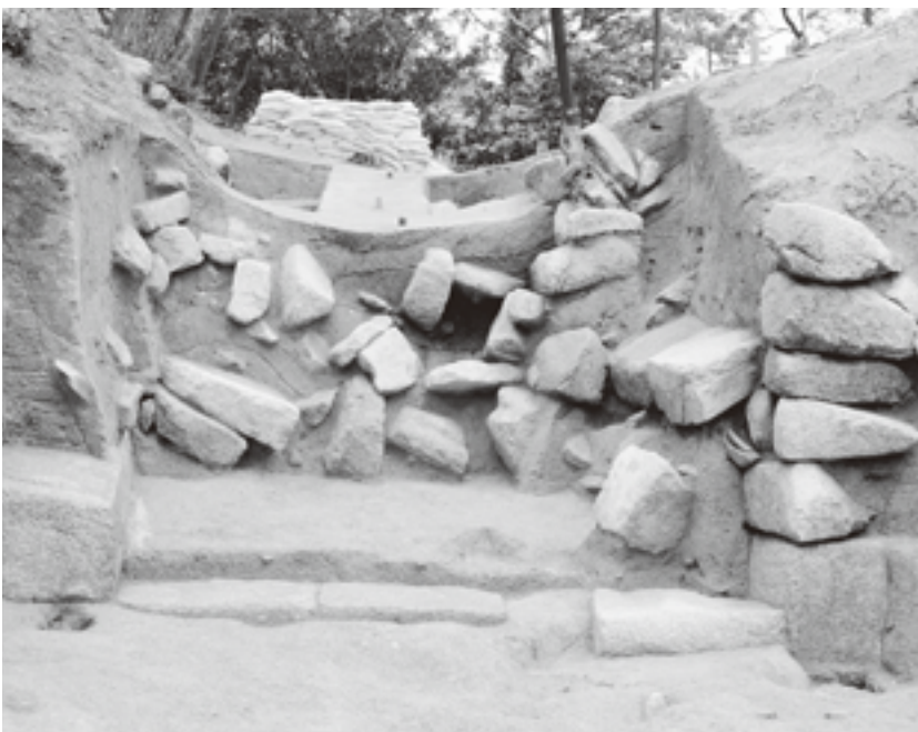
3. 崩落状況断面
