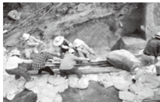
第15図 崩落石材の撤去（第2東門）
