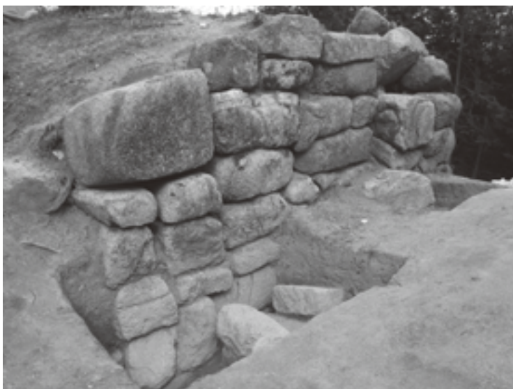
3. 側壁の石積み
