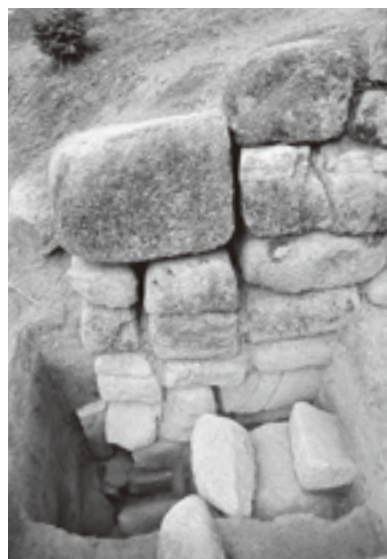
4. 石積みの状況
