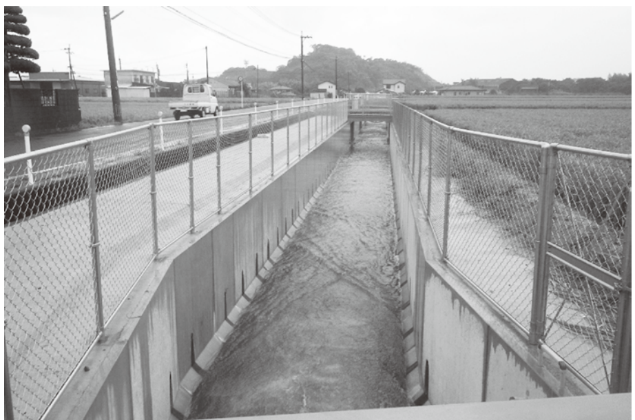
3. 完成した水路（北西から）
