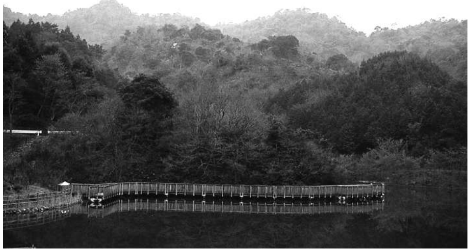
1. 北西外郭線遠景 (北東から)
