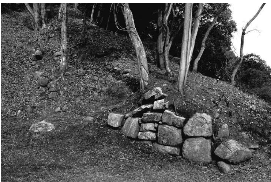
3. 背面西側石塁 (南東から)
