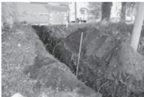
G. 中央第二宿舎給水設備改修工事（北より）調査番号：2018
