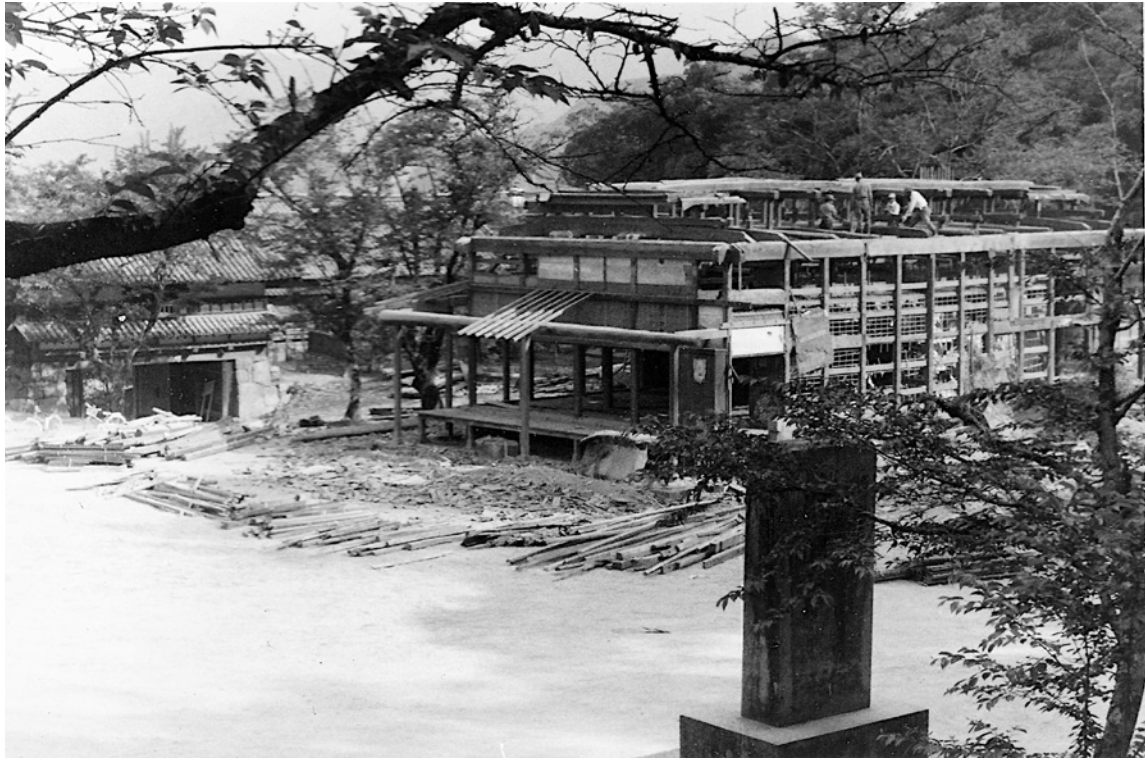
写真19 昭和45年 三の丸御殿の解体状況 小野英治氏画像提供
