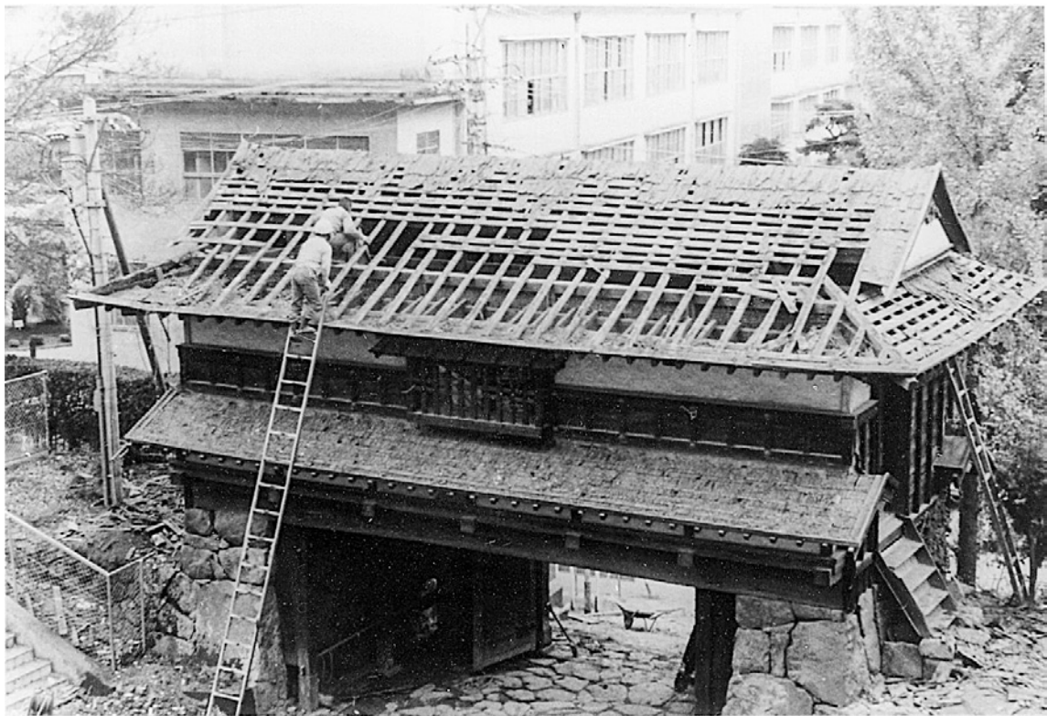
写真20 昭和50年 三の丸櫓門の屋根修理状況
