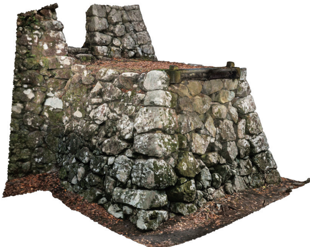
石垣No.109・110隅角部
