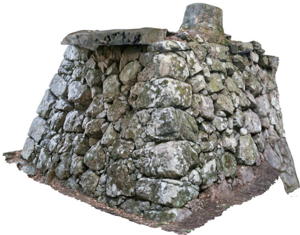
石垣No.302・303隅角部
