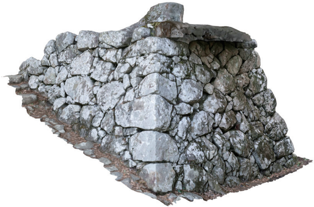
石垣No.301・302隅角部
