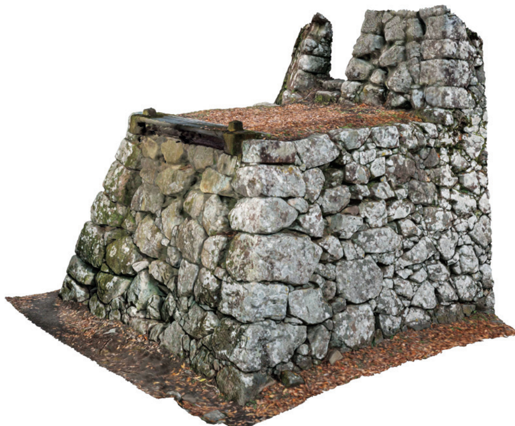
石垣No.110・111隅角部
