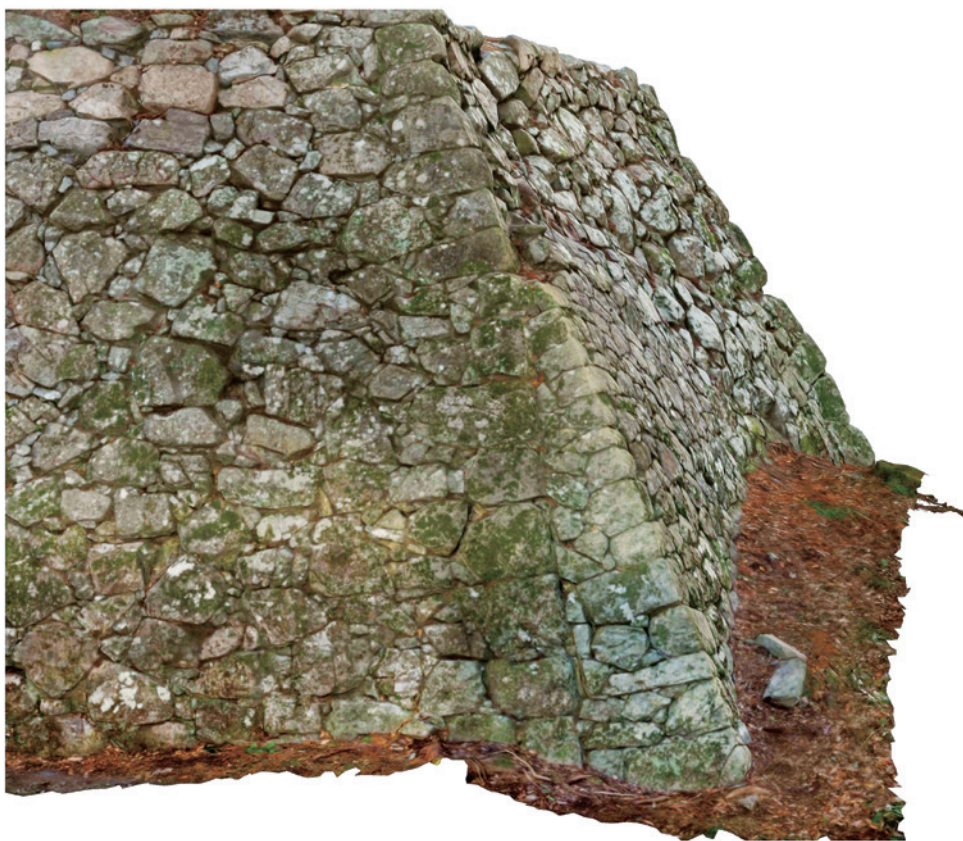
石垣No.323・324ハバキ石垣
