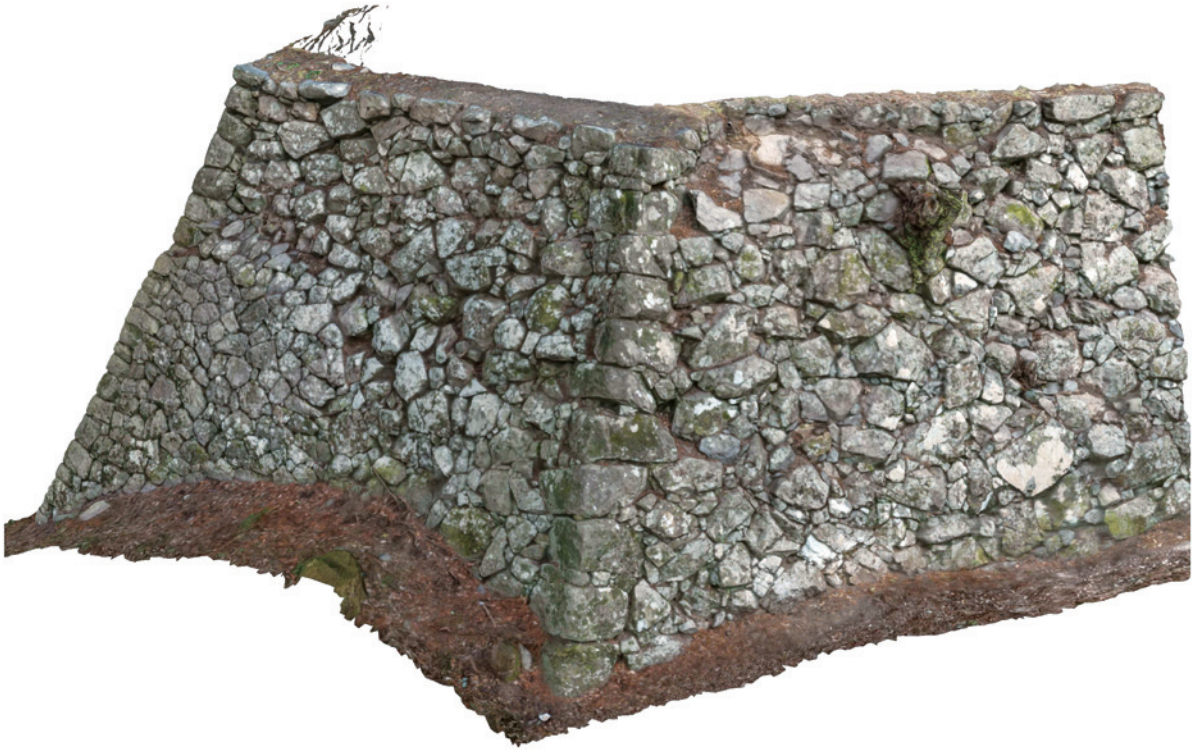
石垣No.324・325隅角部
