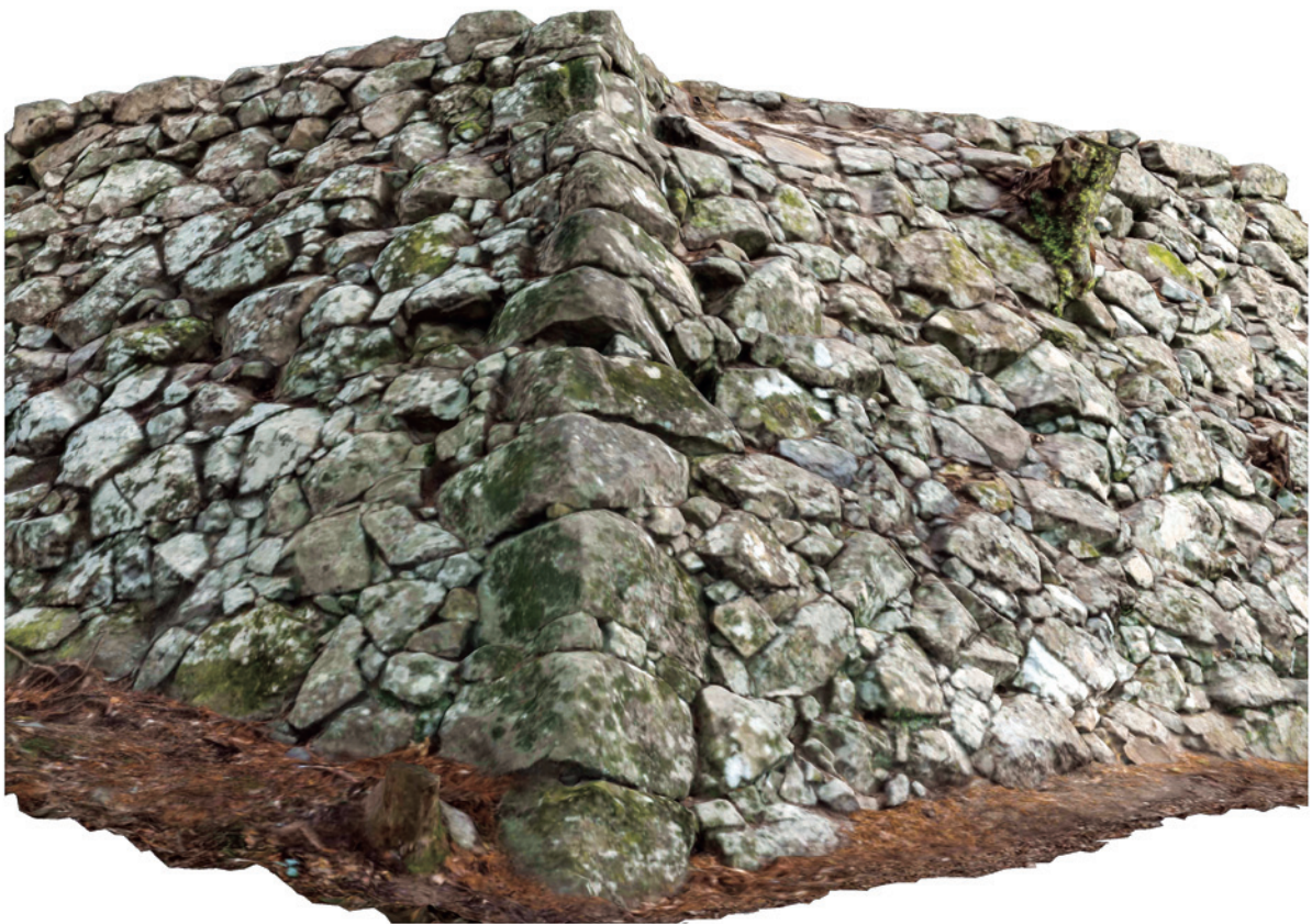
石垣No.324・325隅角部下部
