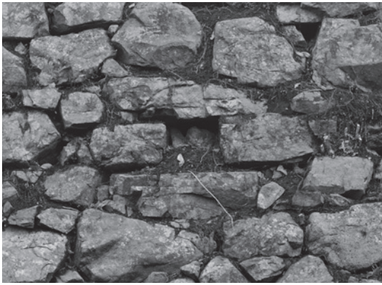
図68 No.414の排水口
