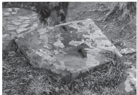
図61 No.311・312隅角部上面の矢穴列
