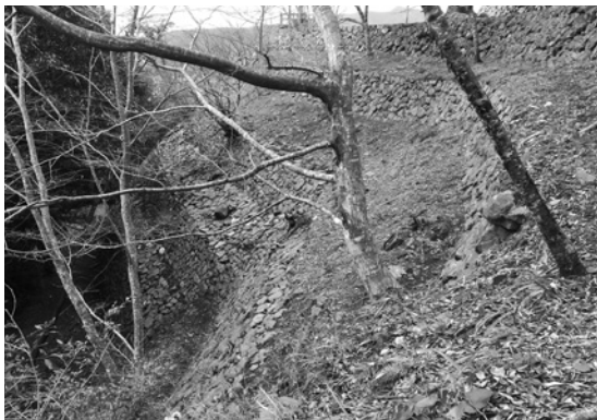
図55 No.234 ~ 237検出状況
