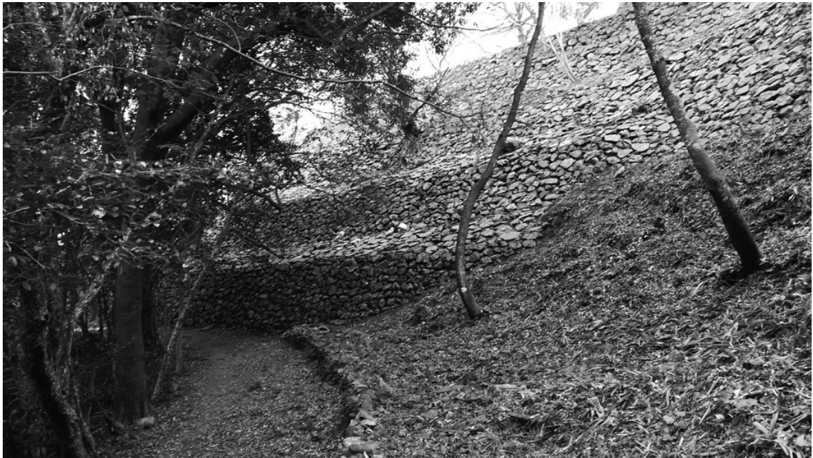
図54 No.234 ~ 237検出状況
