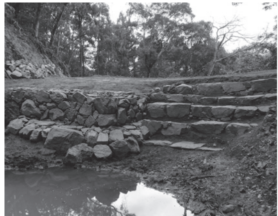
図85 復旧後の雌池石垣 (No.713・714)
