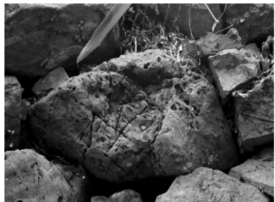
図50 表面に多数の小穴がある築石
