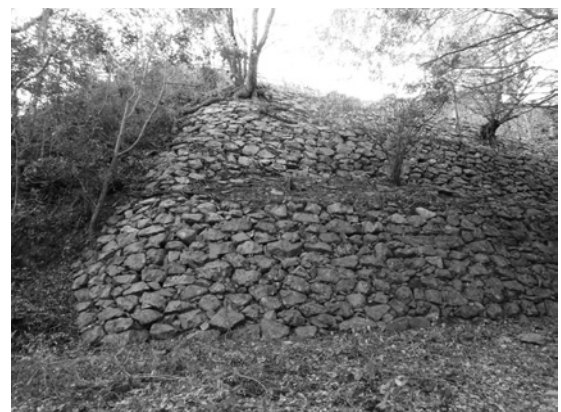
図53 No.238検出状況
