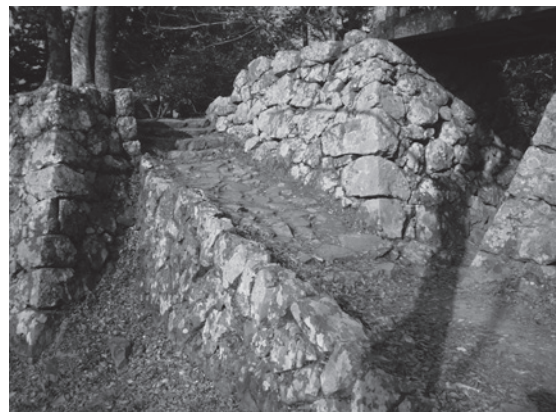
図58 廊下橋下の石垣（No.301・302）
