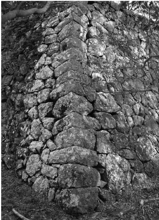
図47 本丸北西隅石垣 (No.116・117)
