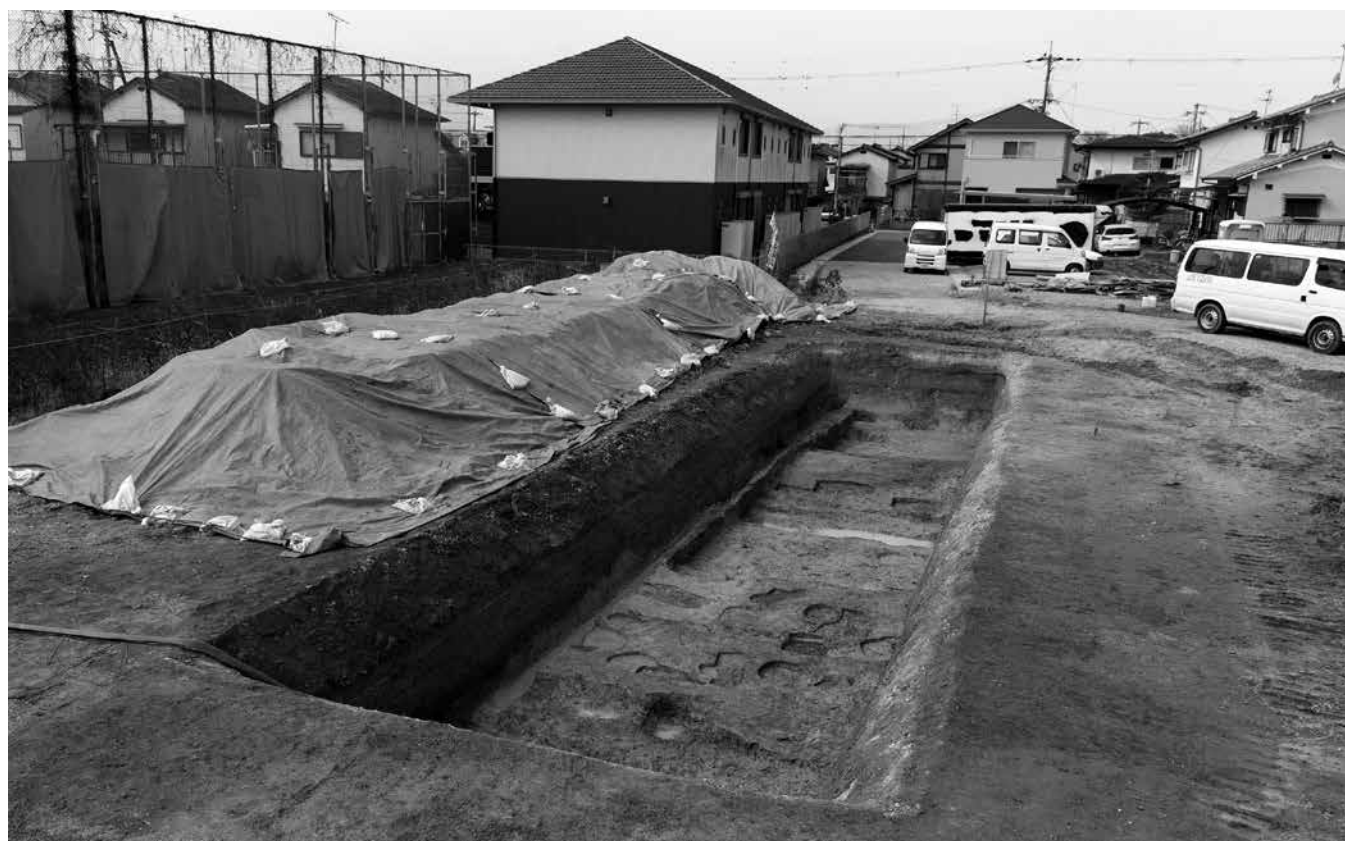
HJ 第 743 次調査 発掘区全景（北東から）
