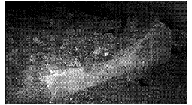
第6図 長島山6 コンクリート基礎残存状況
