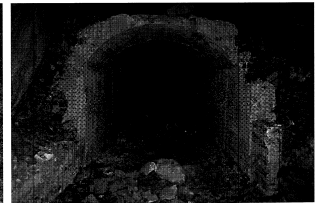
濃霞山 19 内部施工途中
