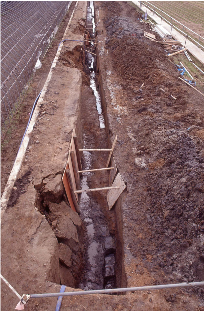
第2トレンチ全景 (北から)
