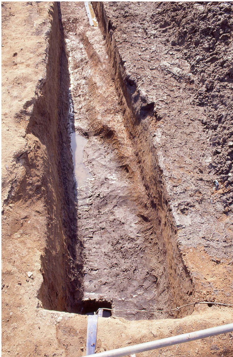
第2トレンチ SD-102E・102F 完掘状況 (北から)
