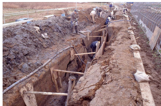
第2トレンチ作業風景（南から）
