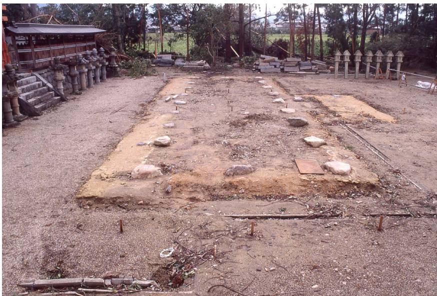
拝殿解体後の基壇 (西から)
