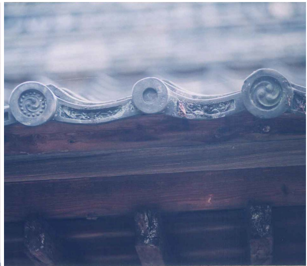
北側の棧瓦軒先部
