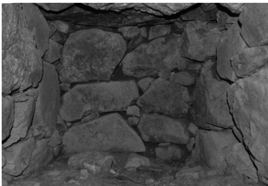
41 H11号墳 石室 奥壁
