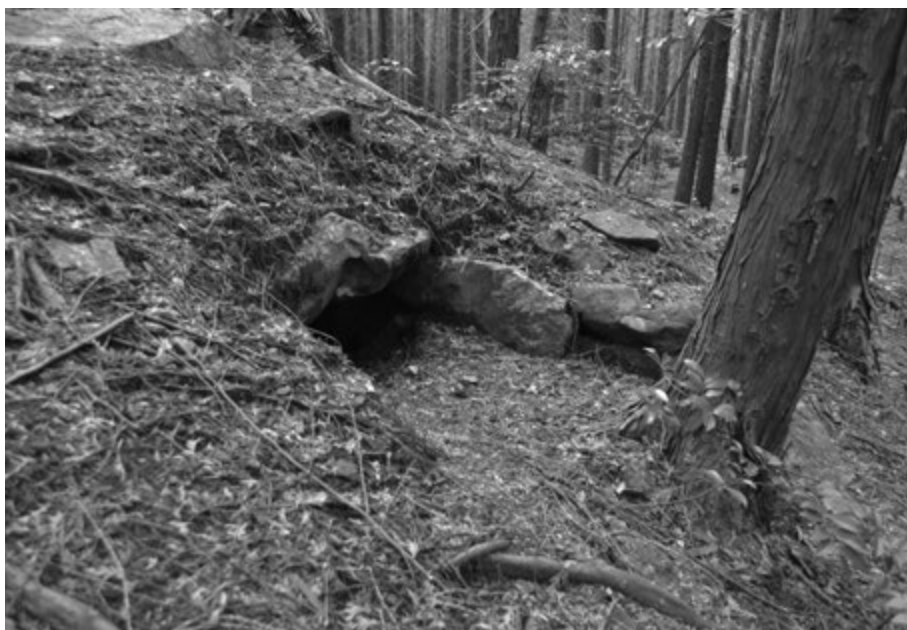
39 H11号墳 石室 開口部露出状況
