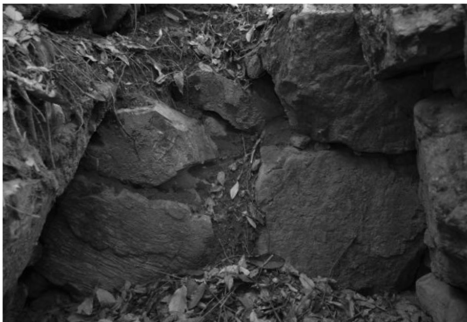
76 H41号墳 石室 奥壁
