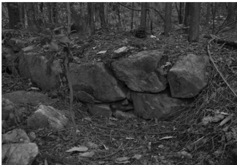
77 H41号墳 石室 左側壁残存状況 (北東から)
