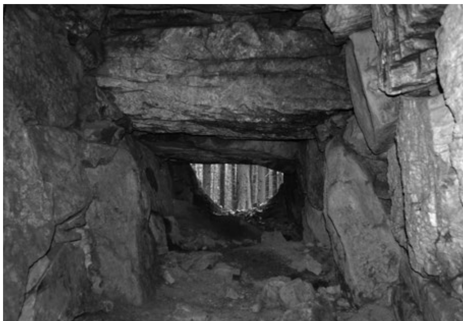
66 H24 号墳 石室 前壁・袖部
