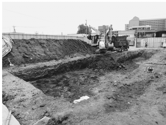
重機表土除去
