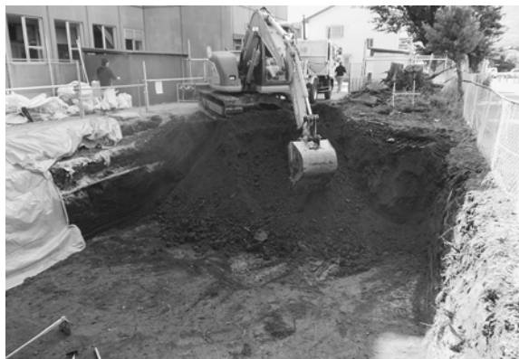
重機表土除去
