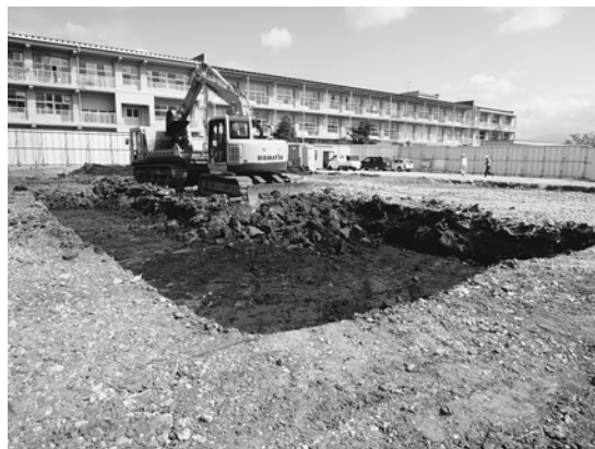
重機表土除去
