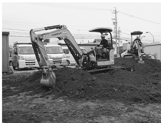
重機表土除去
