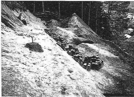
I 帯郭空堀完堀状況
