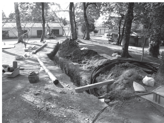
図46 6 Tr.全景写真 (北から)
