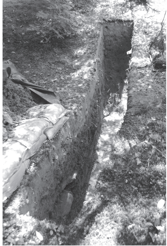
図 112 3区全景（北から）
