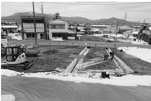
4. 暗渠設置状況（西から）
