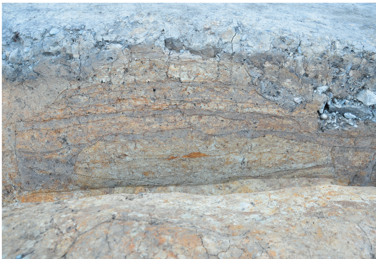
33次 築地塀断面（南から）
