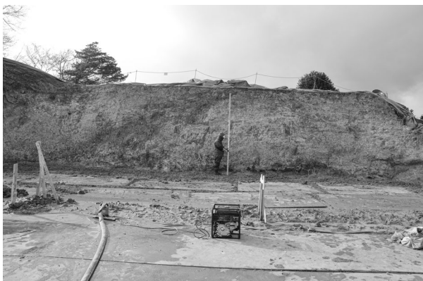
7. 40次 土塁調査（東から）
