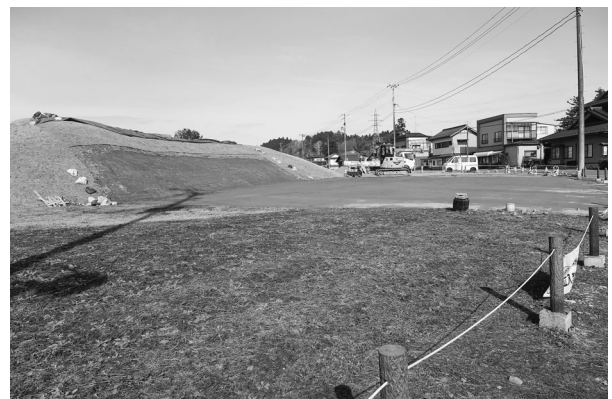
5. 土塁復旧状況（南から）
