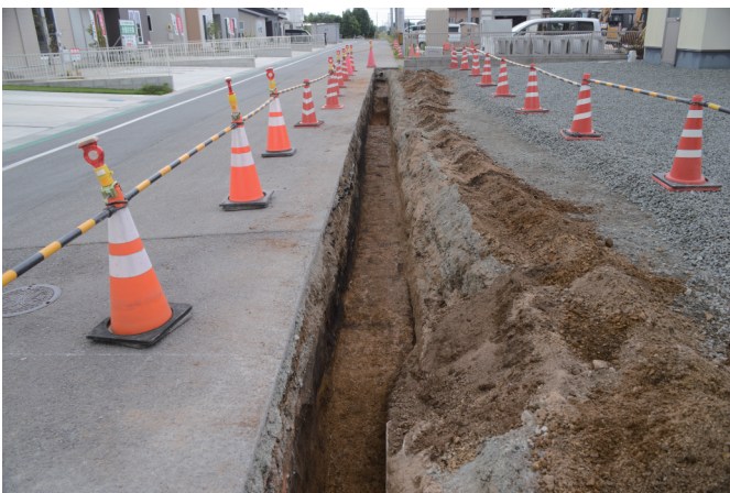
写真図版7 側溝工事立会部分①(西から)
