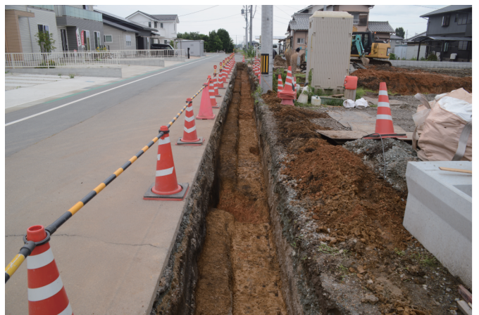
写真図版8 側溝工事立会部分②(西から)
