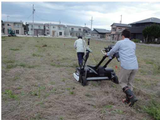
地中レーダー探査の実施状況
