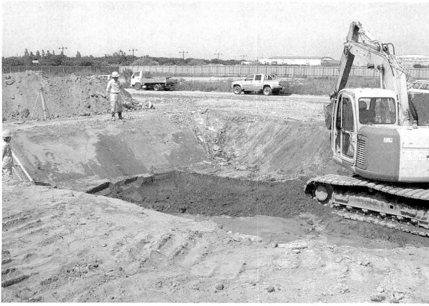
写真19 2T調査状況
