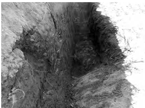
溝の一部掘削 (2)
