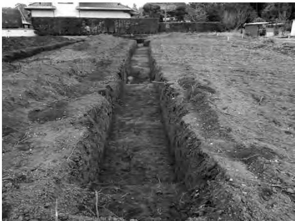
1トレンチ(西から)
