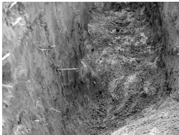
溝の一部掘削 (1)
