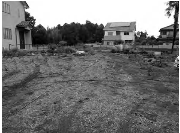
埋め戻し後 (南から)
