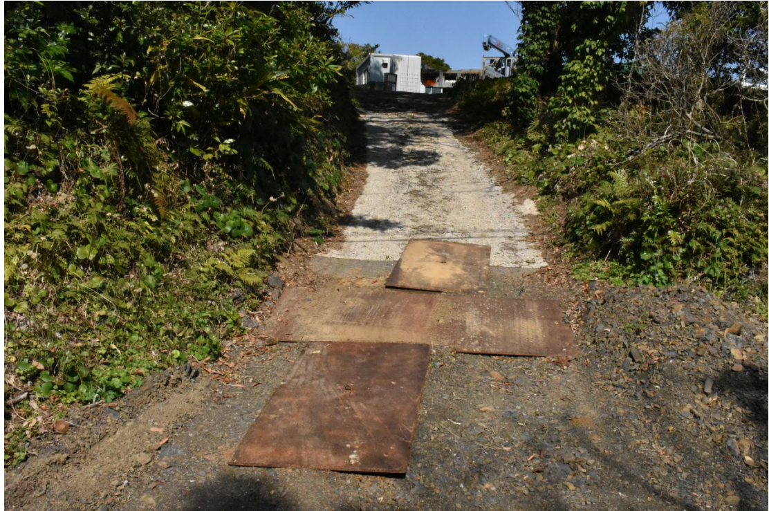
安全敷板使用状況
