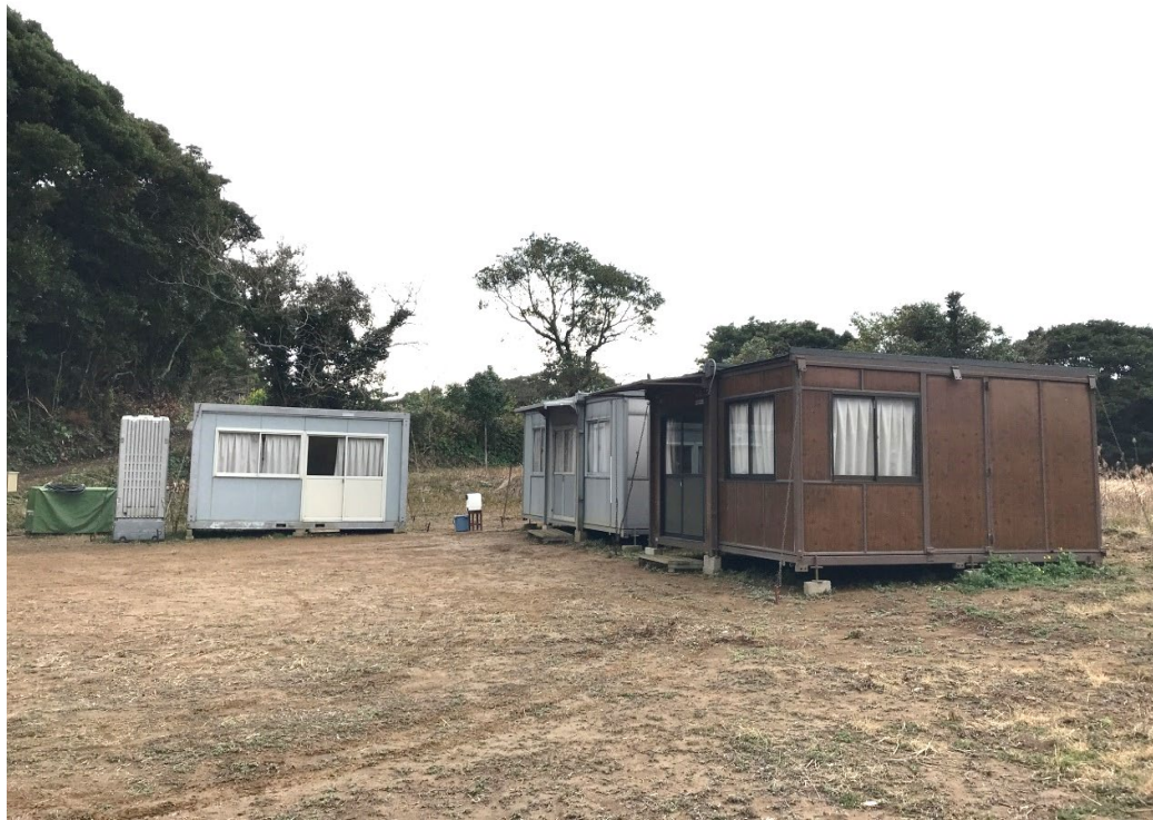
事務所、作業員休憩所、倉庫、仮設トイレ設置状況
