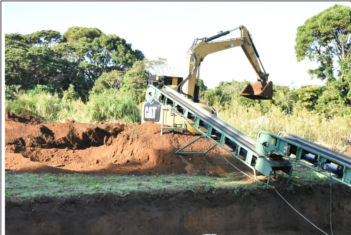
重機排土処理作業
