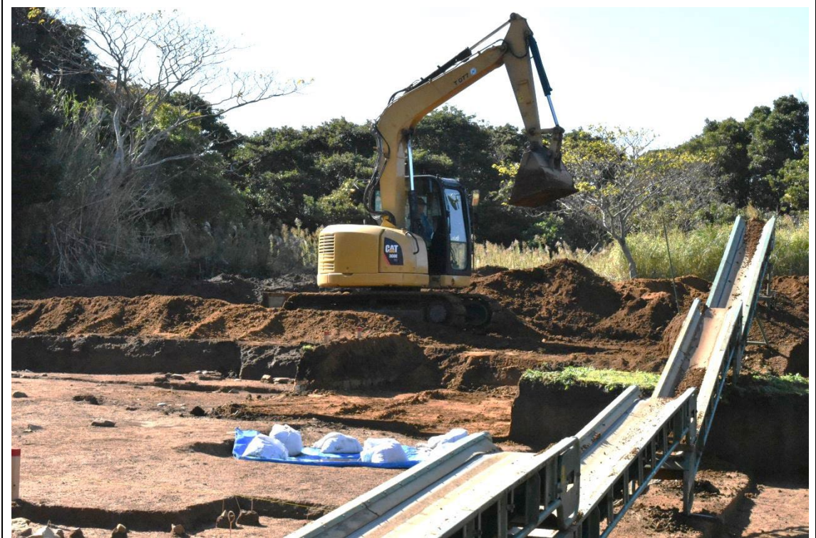
重機排土処理作業
