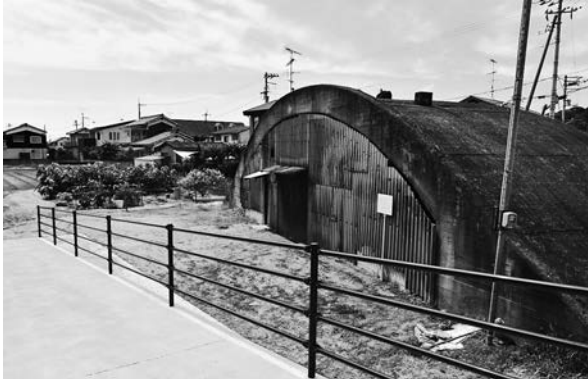
写真1 掩体壕周辺状況①（南東より）
