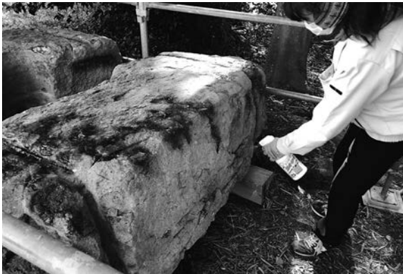
写真3 生物除去剤噴霧作業風景
