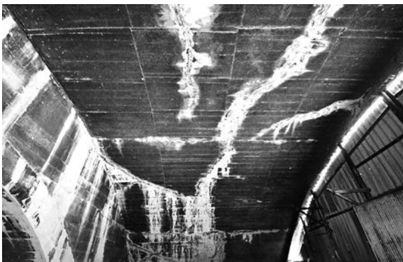
写真6 1区掩体壕内面型枠痕（西より）
