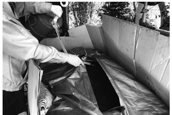
写真6 強化剤含侵作業状況
