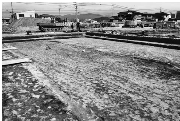
写真 14 4 区全景（北西より）
