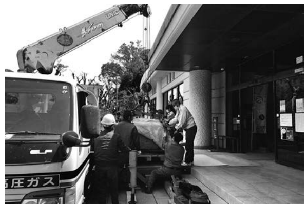
写真8 館内設置作業状況
