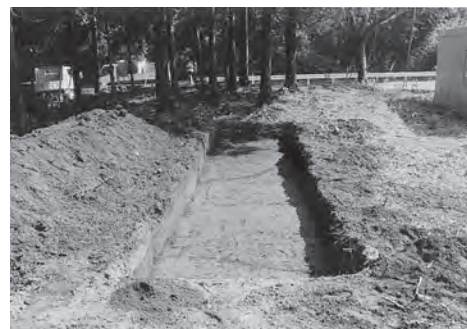
4 T遺構検出状況
