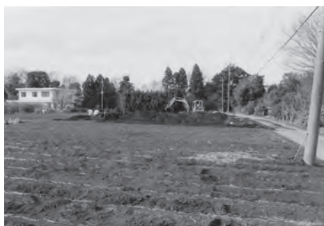
重機稼働状況
