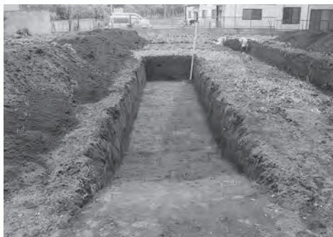
2 T 遺構検出状況
