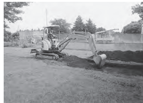
重機稼働状況
