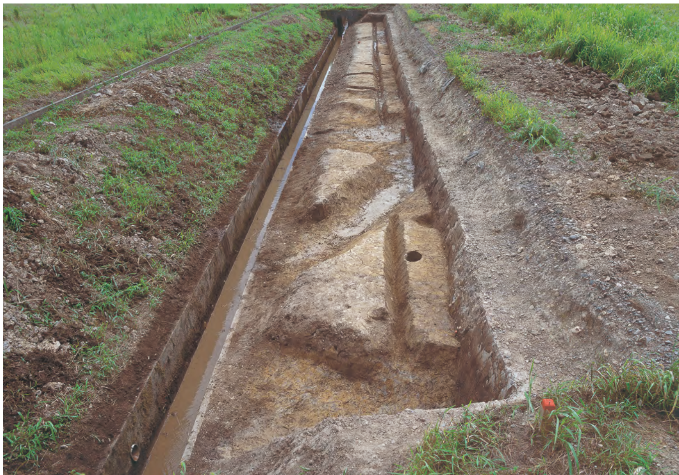
4区 (70-1B・2B・2C・3C 付近) 完掘状況 (北西→南東)
