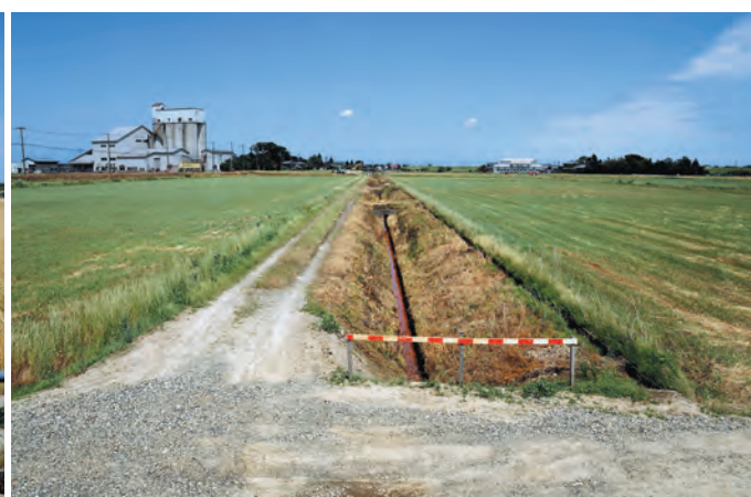
4区調査前現況（南東→北西）
