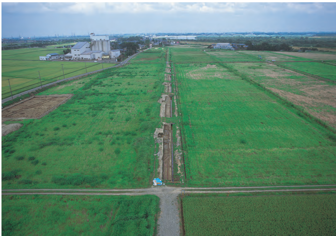
4区全景空中写真(南東→北西)
