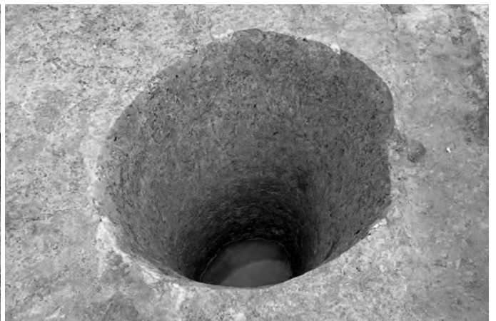
2区 SE110 完掘状況 (北西→南東)
