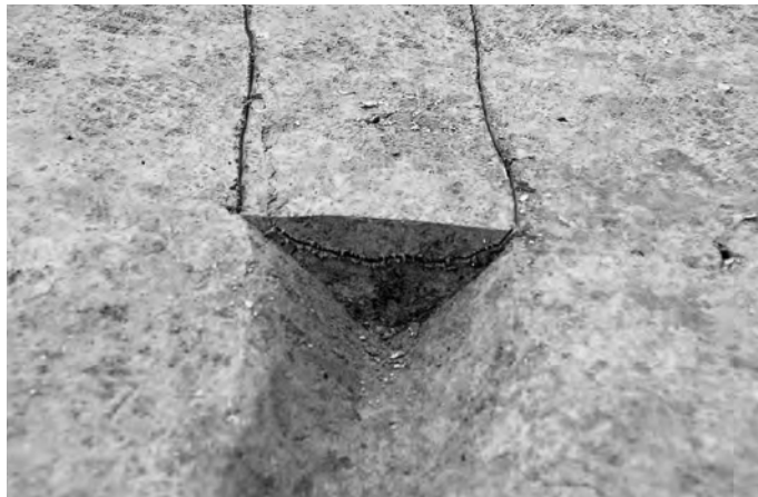
1区 SD19 土層断面 (南東→北西)
