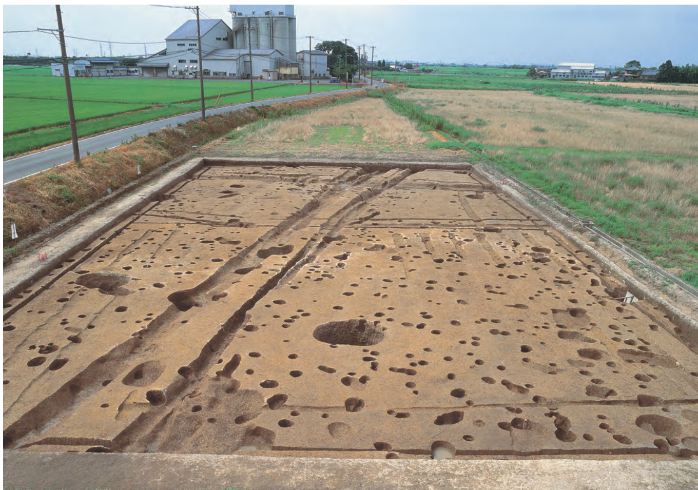
2区完掘状況(南東→北西)
