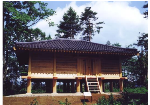
復元された正倉建物
