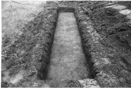
3トレンチ (南から)
