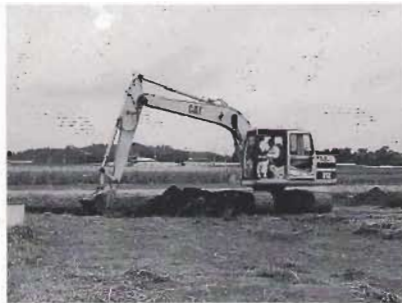
② 調査区が決まったら遺跡の表面を覆う土を重機により除去します。
