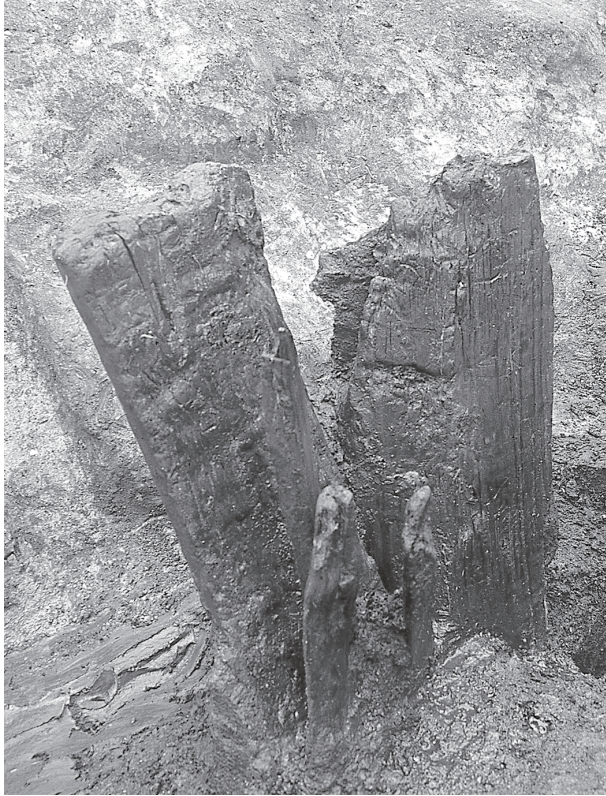
土留部検出 南から
