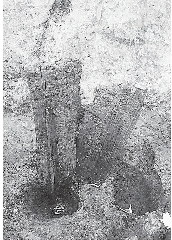
土留部打ち込み状況 南から
