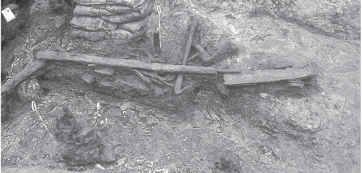
板材検出 北から
