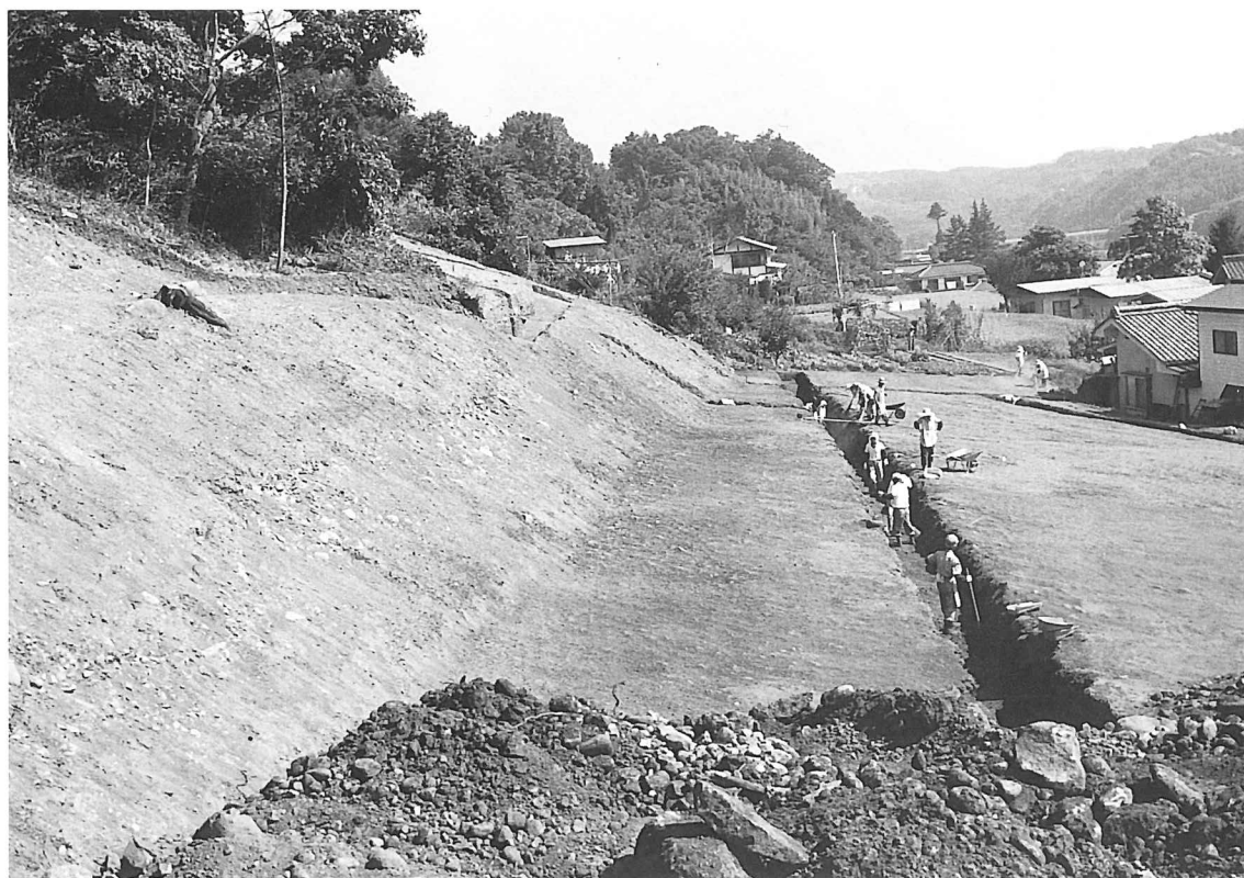
32. トレンチ調査
