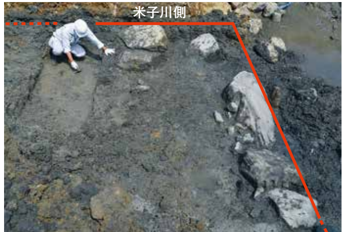
米子橋南西側 橋台南東角部の根石 (西から)
