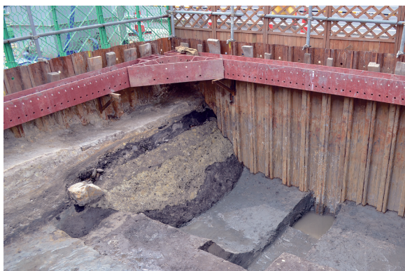
素掘の大溝 (北西から撮影)
