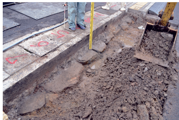
石組水路検出状況（北東から撮影）
