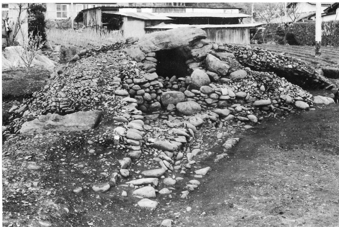
3. 真光寺第1号古墳墳丘石室前庭部全景（落下天井石を取り除く）
