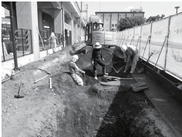
図 5 ①ブロック作業風景（南から）
