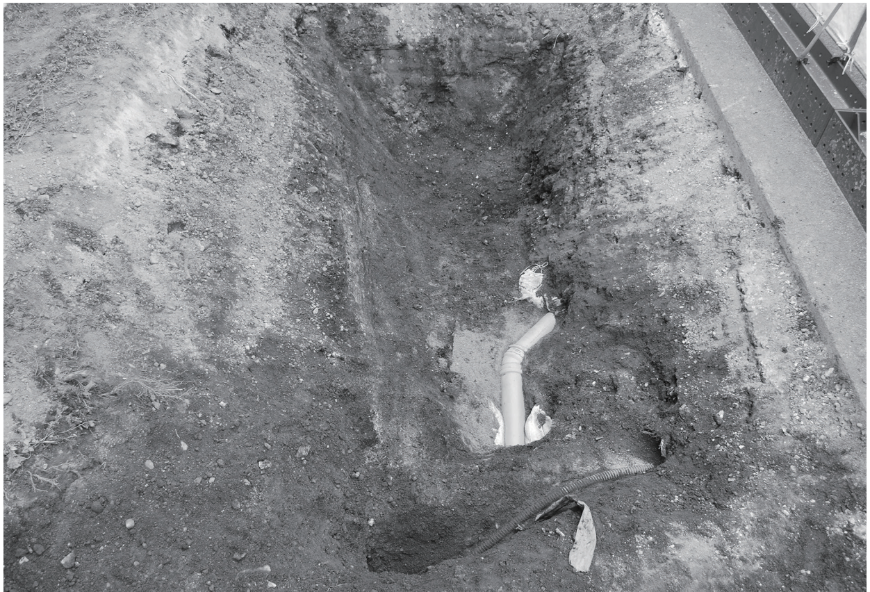
1 ③ブロック北半全景（北から）
