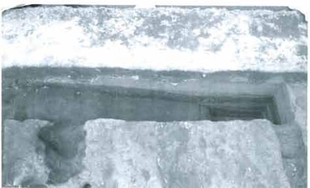
7 SB224(塔跡2) fトレンチ 掘り込み地業断ち割り部(南から)
