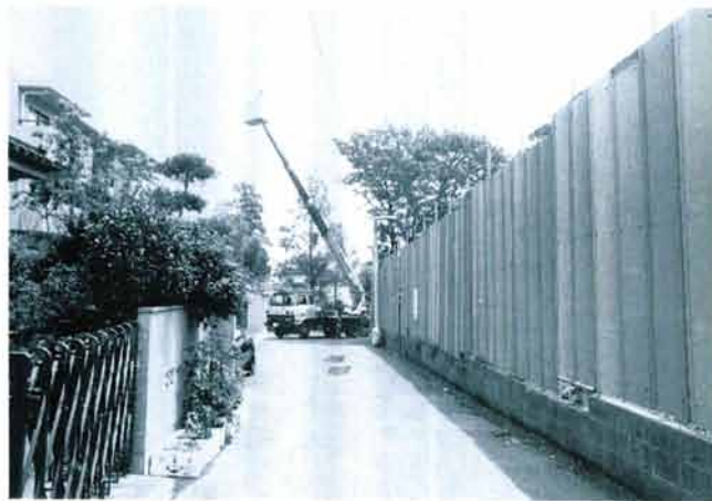
3. ゴンドラ撮影 (西から)
