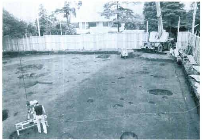
2. 写真実測 (西から)
