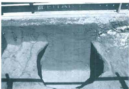
3. SI135J 住居跡内 SK153J 土坑全景 (南から)
