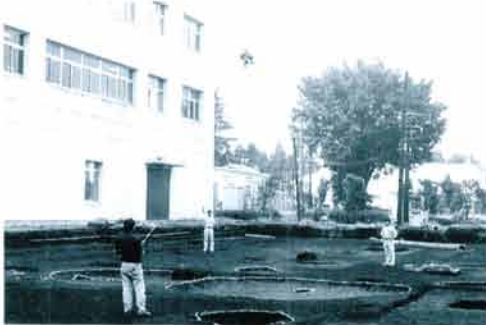
4. 作業風景写真測量
