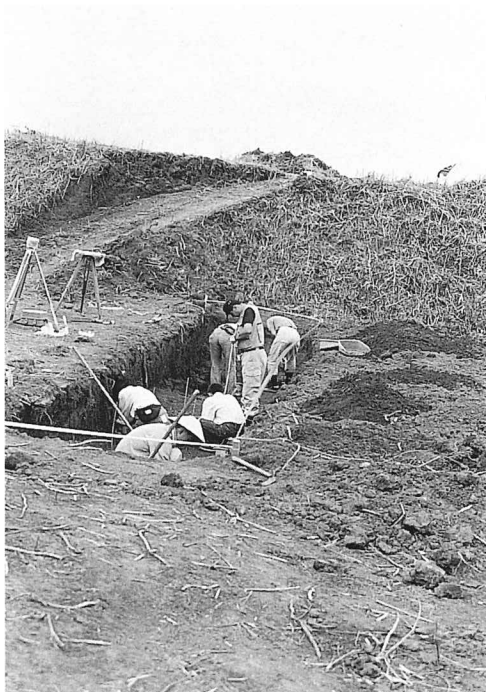
作業風景(第4トレンチ)
