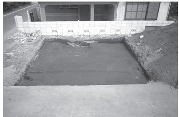
5 第76次調査 調査区全景 (西から)
