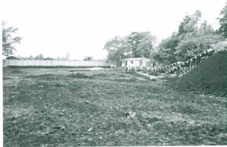
2. 発掘着手時状況（東から）
