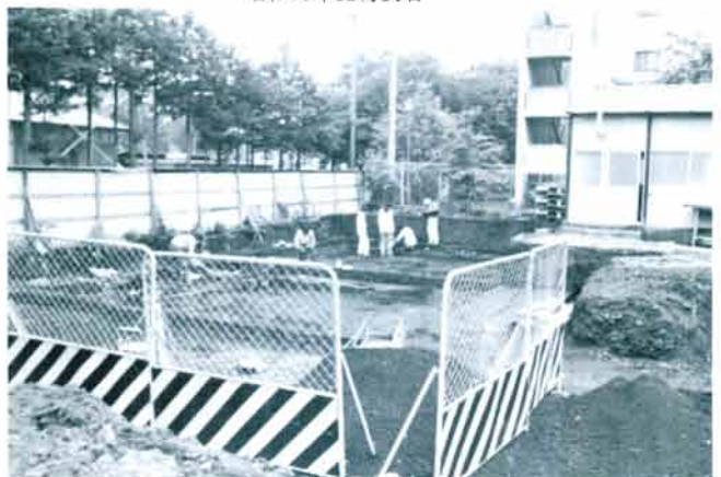
8. 浄化槽部分, 縄文時代遺物分布層発掘 (北から) 昭和54年5月17日
