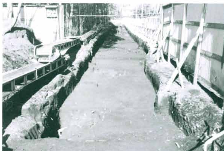
3. GA~GI88・89区（道路部分南北）（南から）
