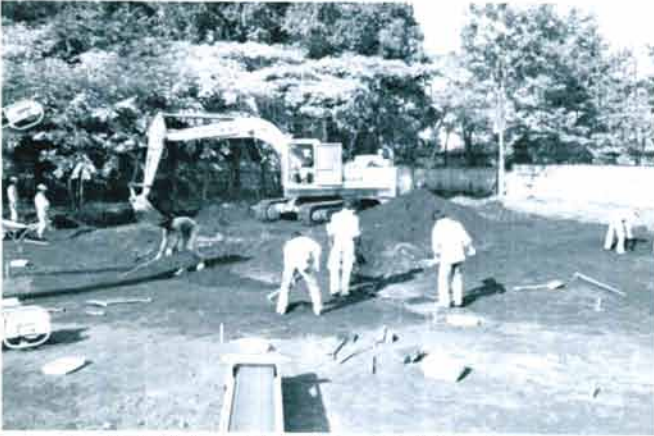
1. 建物部分, 表土 排土, 遺構検出 (南から) 昭和52年10月20日
