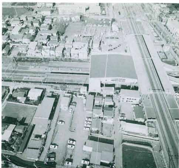
1. 調査地上空より北を望む (JR 西国分寺駅)
