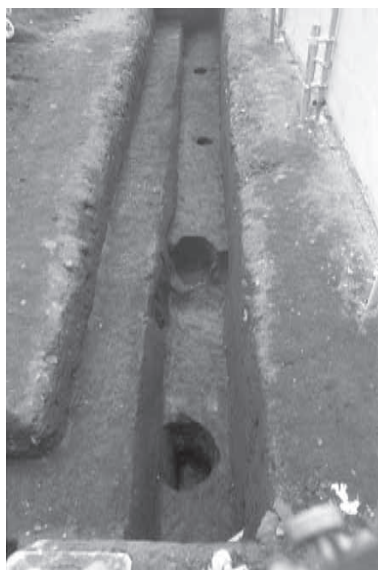
第40図 Aトレンチ全景 (西から)
