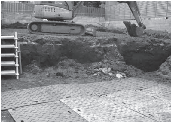
第7図 No.23 立会状況
