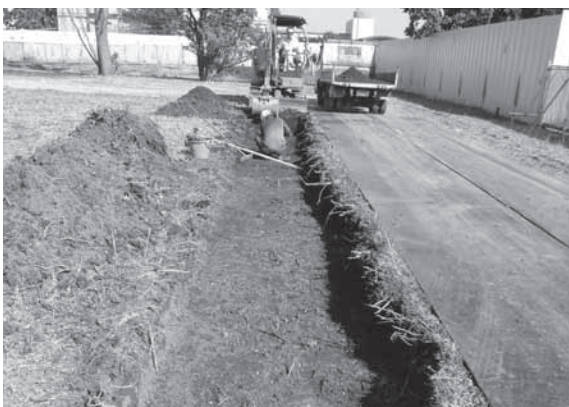
第9図 No.70 立会状況
