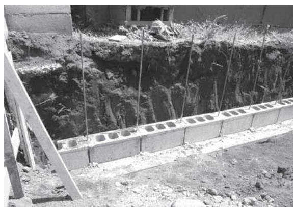
第12図 No.205 立会状況
