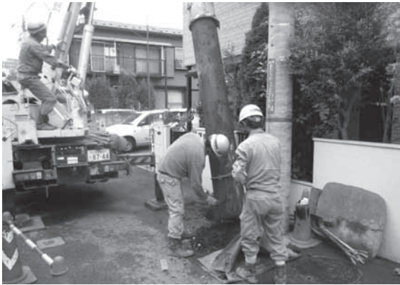
第5図 No.3 立会状況
