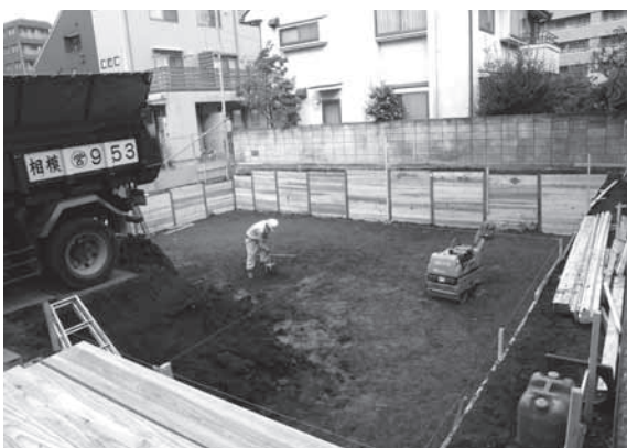
第11図 No.106 立会状況
