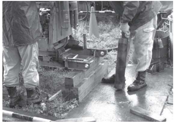
第6図 No.6 立会状況
