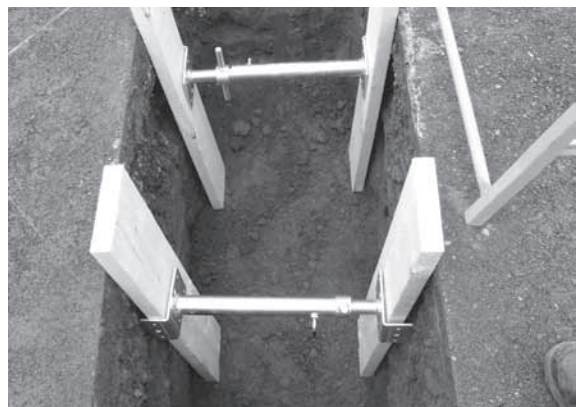
第10図 No.73 立会状況
