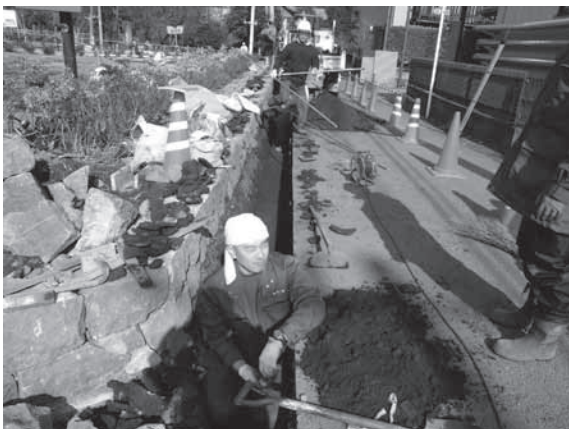
第3図 No.148 立会状況(1)
