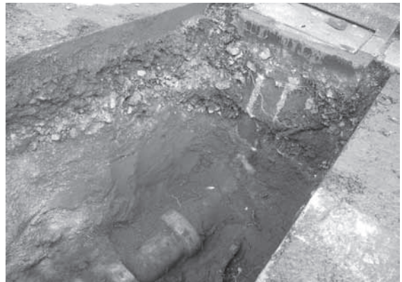
第8図 No.33 立会状況
