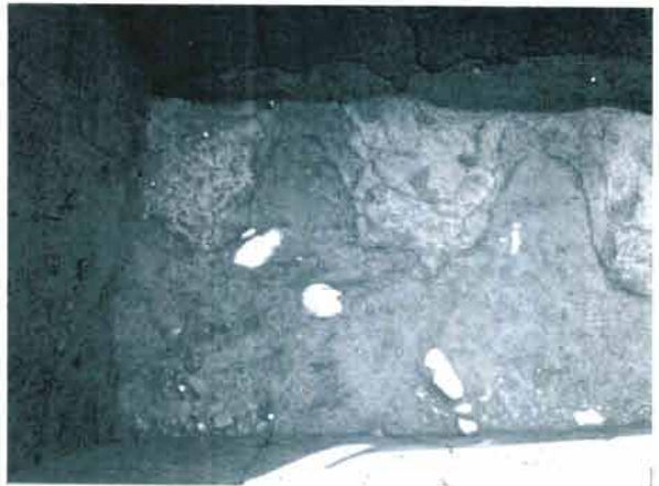
第134図 SF5 確認状況南側近影 (東から)
