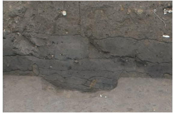
第 13 図 SK3430 南壁 (北から)
