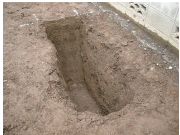
第 93 図 B トレンチ完掘状況 (北東から)
