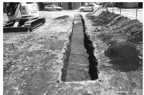
Bトレンチ全景(西から)
