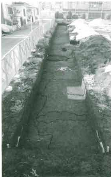
1. Aトレンチ全景 南から
