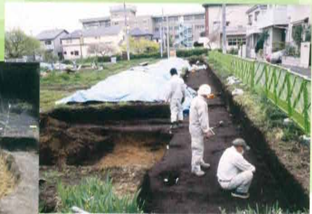
(武蔵国分寺跡⑥地区(西元町2丁目)調査作業風景)
