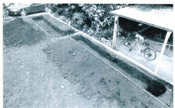
2. B,Cトレンチ全景 東から
