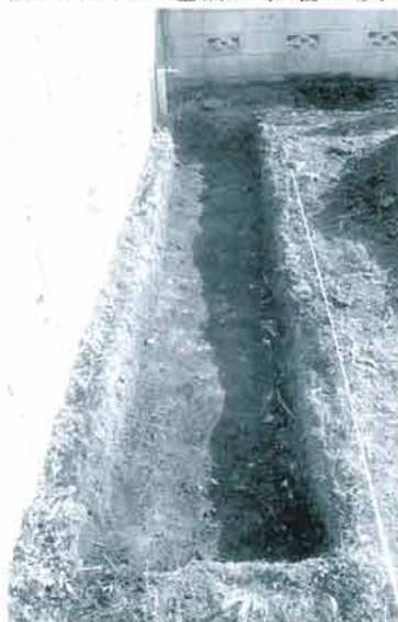
1. A トレンチ全景 西から
