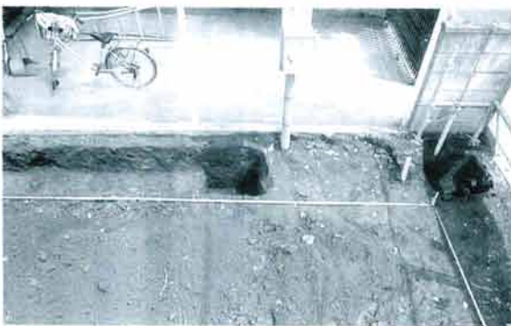
1. Aトレンチ全景及びBトレンチ東側 南から
