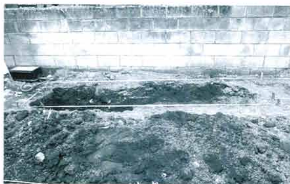
2. 調査区全景西側 南から
