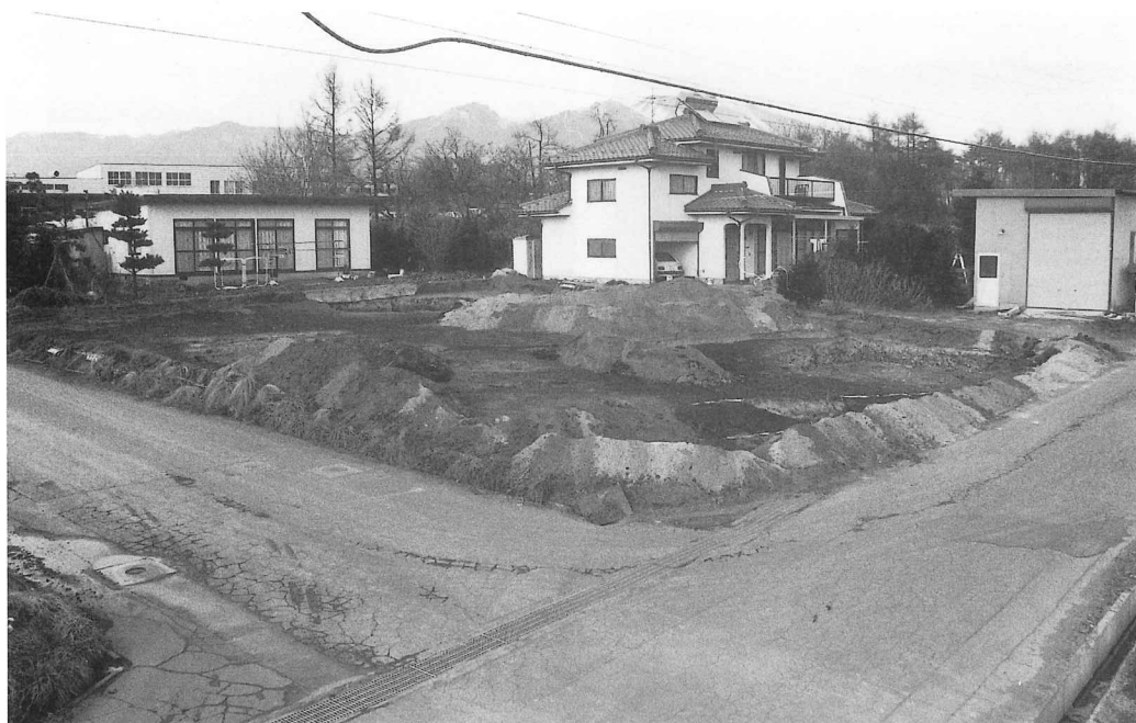
調査第Ⅲ区全景（南西より）
