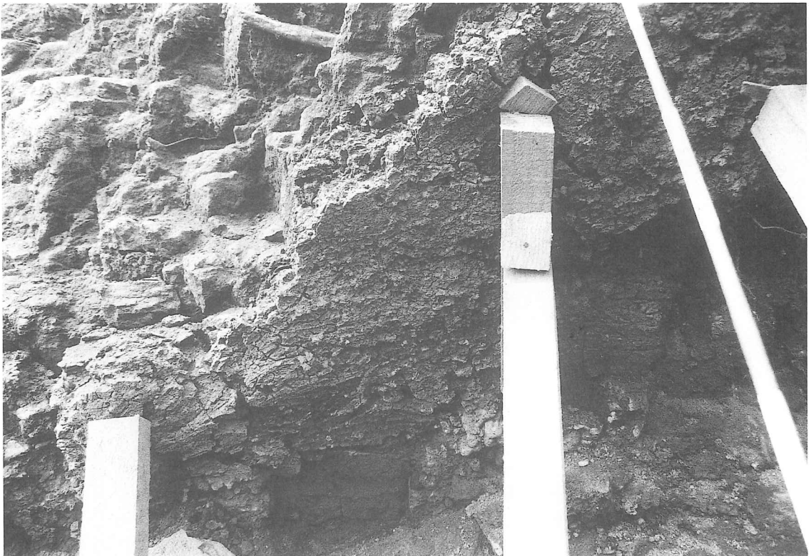
同 スサ入り粘土貼壁の状況
