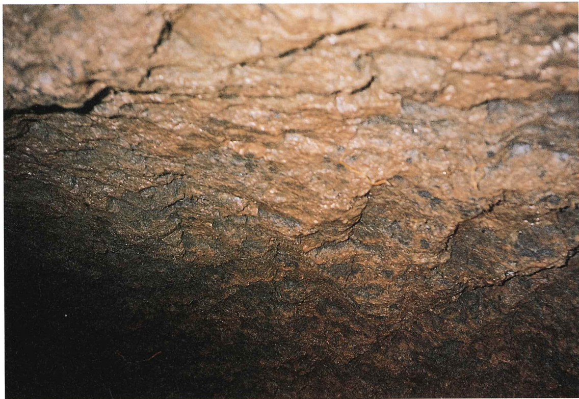
I Z 5 号窯址窯体壁面（焼成部）
